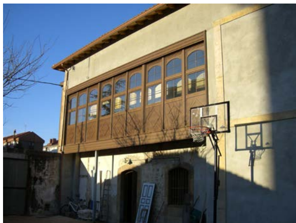
Figura 2: Galería fachada SO
