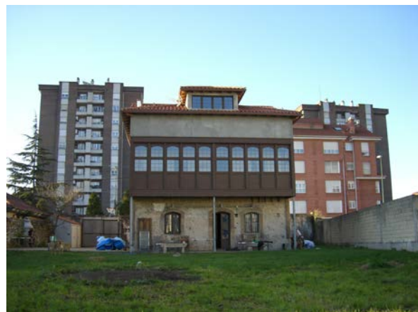
Figura 3: Galería fachada SE
