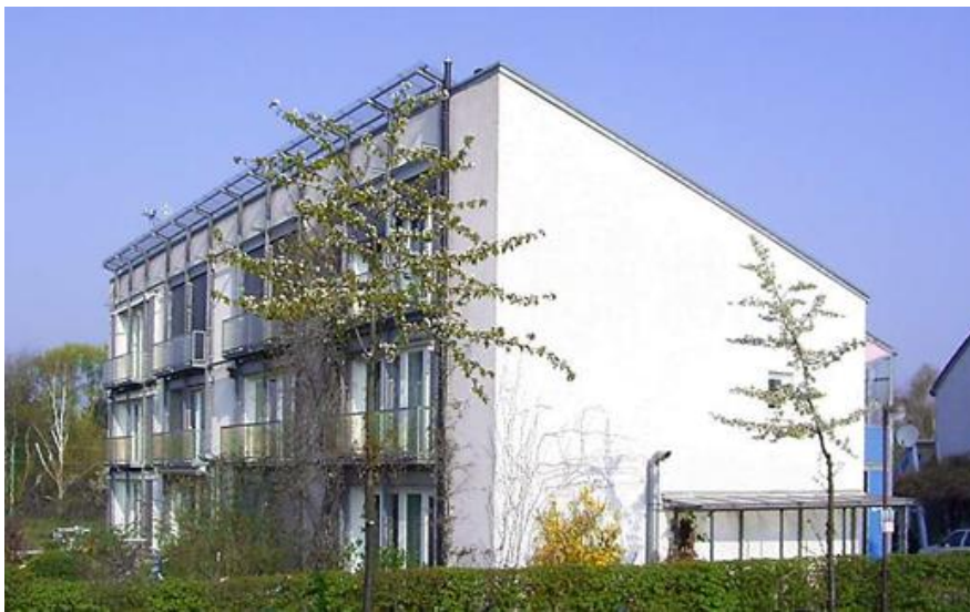
Ilustración 10. Primer edificio certificado con el estándar Passivhaus.
