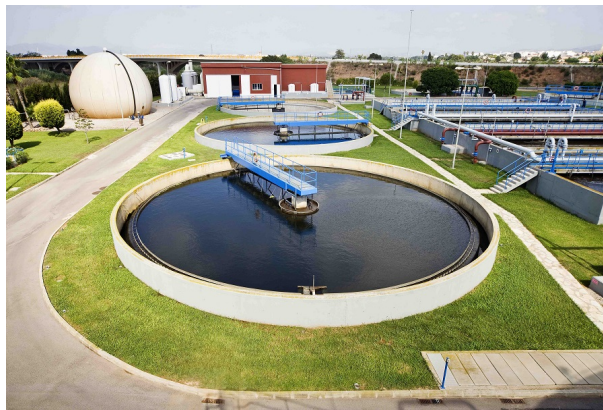
Figura 2.3.: Instalación EDAR para el tratamiento de aguas residuales
