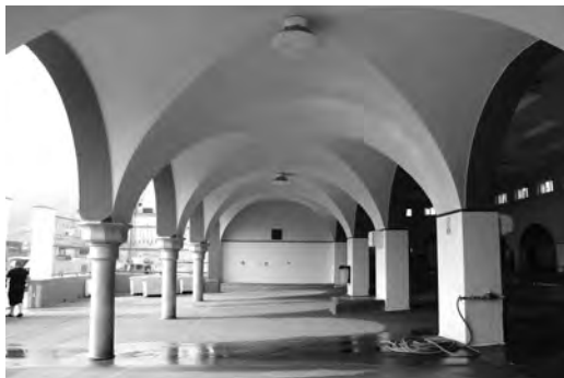
Figura 15 Imagen actual de las bóvedas de rincón de claustro de la lonja de pescadores de Cartagena, España (V. La Spina, 2018)
