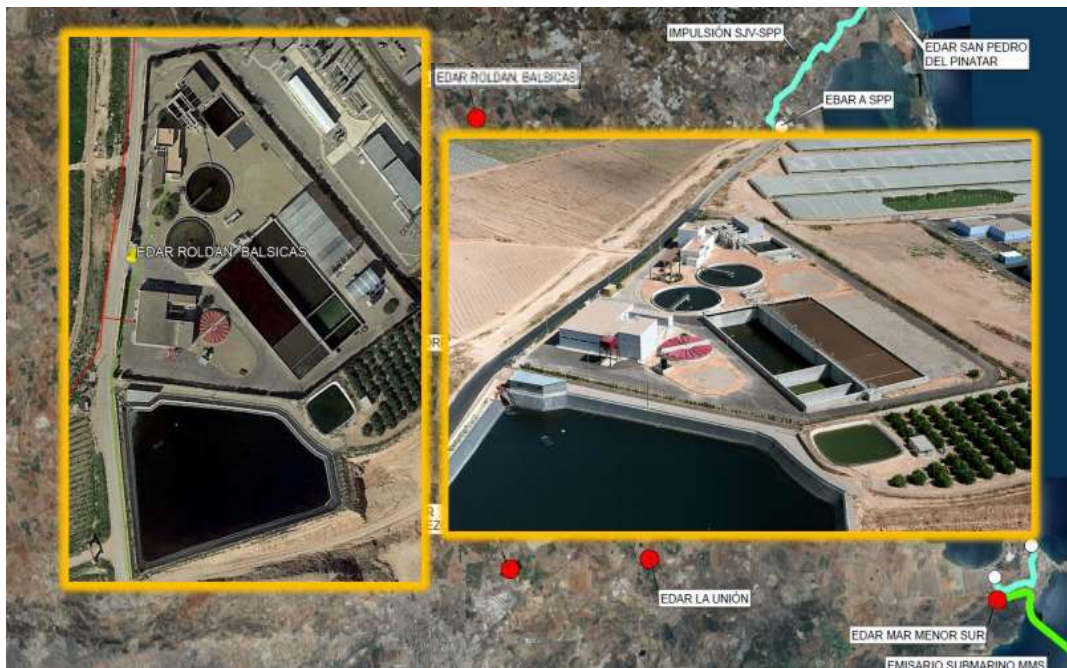
Figura 22. Sistema de depuración Roldán, Lo Ferro y Balsicas (Esamur, 2018)
