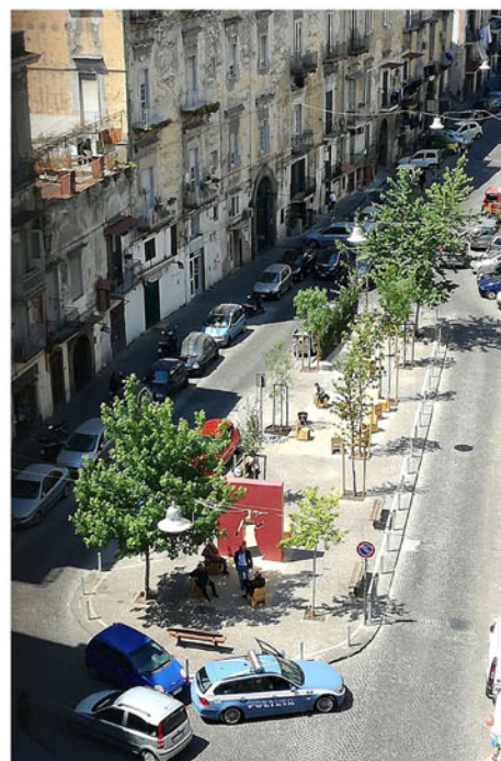
[9] LARGO TOTÒ ALLA SANITÀ VISTO DAL PONTE DI SANTA TERESA DEGLI SCALZI ALLA FINE DEI LAVORI DI SISTEMAZIONE URBANA (2016).
