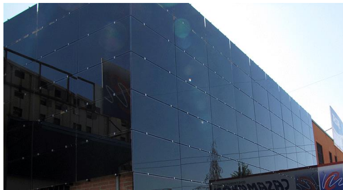
Imagen 6. 2. Resultado de la combinación de fachada ventilada con placas solares
