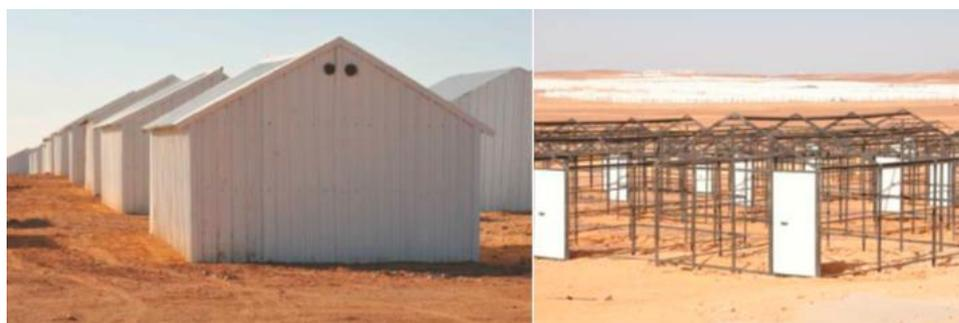
*Ilustración 16. Refugio con estructura de acero [14]*
