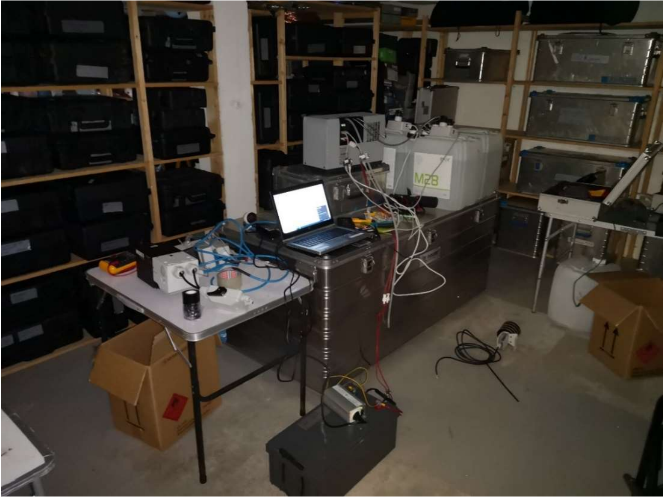
Figura 5.8 Todo el sistema que se procedería a instalar
