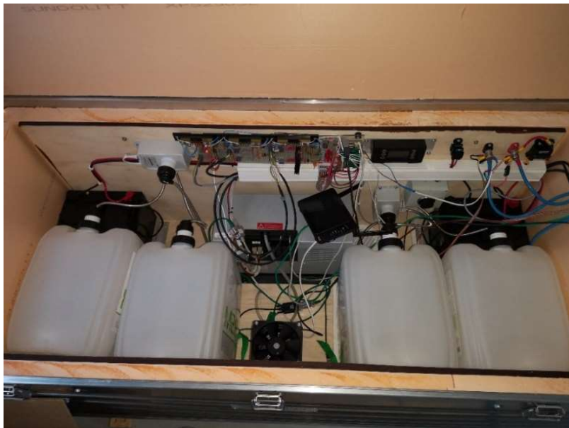
Figura 5.3 Dentro de la caja de metal, con la pila de combustible, 4 bidones de combustible y los cables
