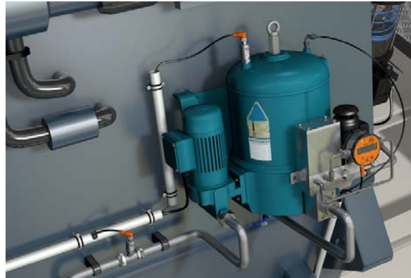
Figura 41. Sistema de filtrado de aceite (Fuente: [42])
