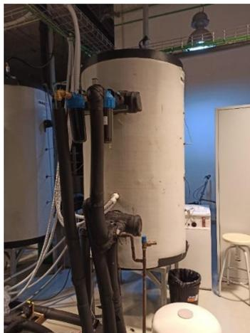
*Ilustración 22 Depósito de Agua del Circuito de Agua Fría y la máquina de refrigeración de la Instalación.*
