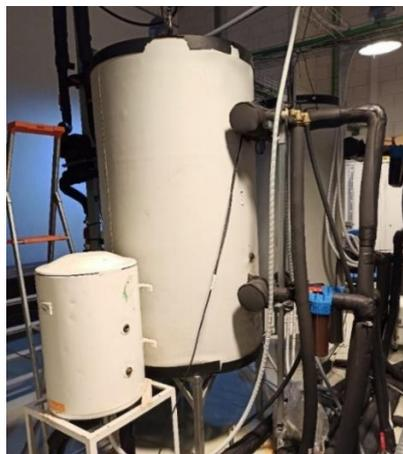
*Ilustración 24 Depósitos de 750 y 50 litros del Circuito de Agua Caliente de la Instalación.*
