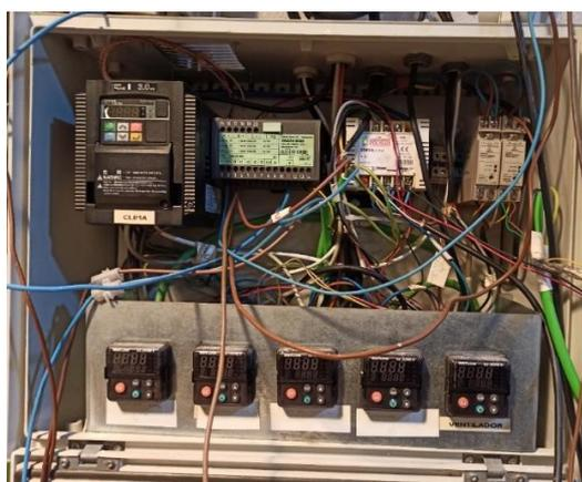
Ilustración 36 Caja de Controladores PIDs de la Instalación.
