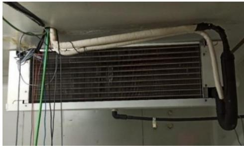
*Ilustración 27 Unidad Auxiliar de Refrigeración dentro de la Cámara Climática.*
