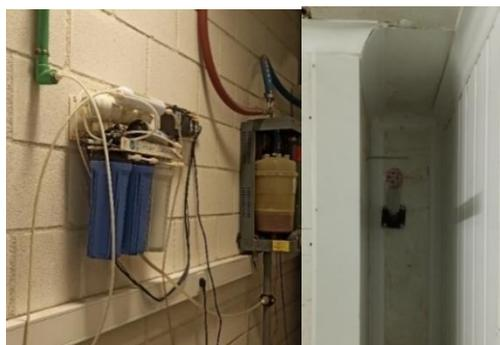
*Ilustración 29 Unidad Humectadora fuera de la Cámara Climática (Izquierda) y su entrada dentro de ella (Derecha).*
