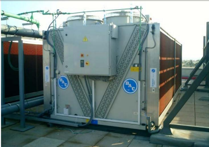
El aero-refrigerador con preenfriamiento adiabático opera como los aeroenfriadores secos mejorando sus prestaciones con un preenfriamiento adiabático del aire de entrada. La temperatura seca del aire de entrada se consigue disminuir a medida que pasa a través de un relleno evaporativo especialmente diseñado para humectar y enfriar la corriente de aire de entrada al equipo sin formación de aerosoles ni agua arrastrada sobre el serpentín seco.
