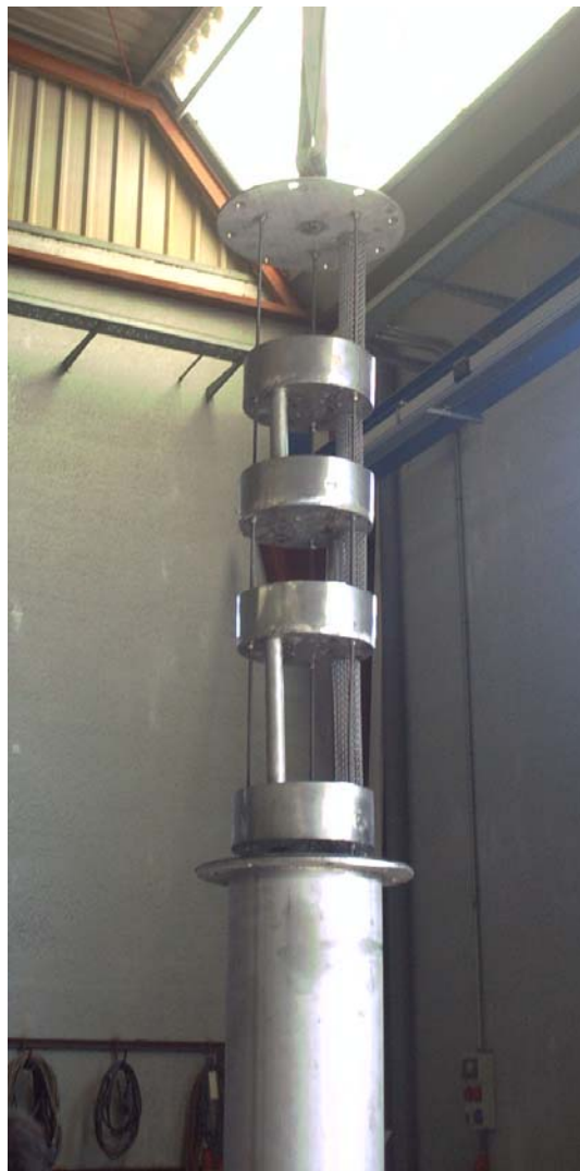
Figura 2. 4- Ensamblaje columna Planta Piloto
