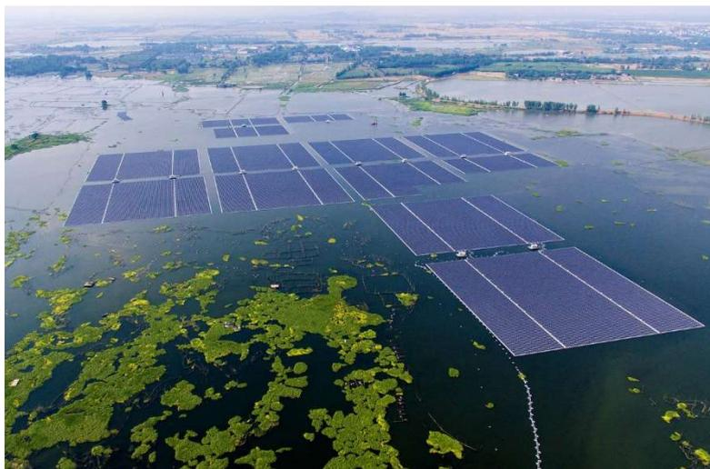
*Imagen 2: Planta solar fotovoltaica flotante en Huainan en China. Fuente: pvbuzz*
