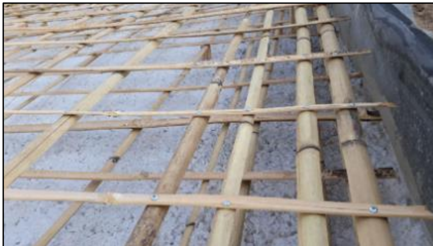
Figura 4.4. Armado con bambú. 82
