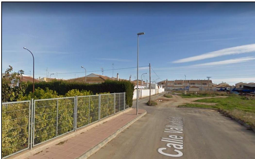
Figura 6.3. Línea eléctrica cercana al aulario. 121
