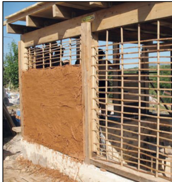
Figura 4.22. Muro de quincha.
