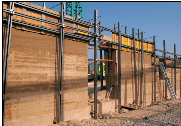
Figura 4.27. Muro de tapial con encofrado industrial.
