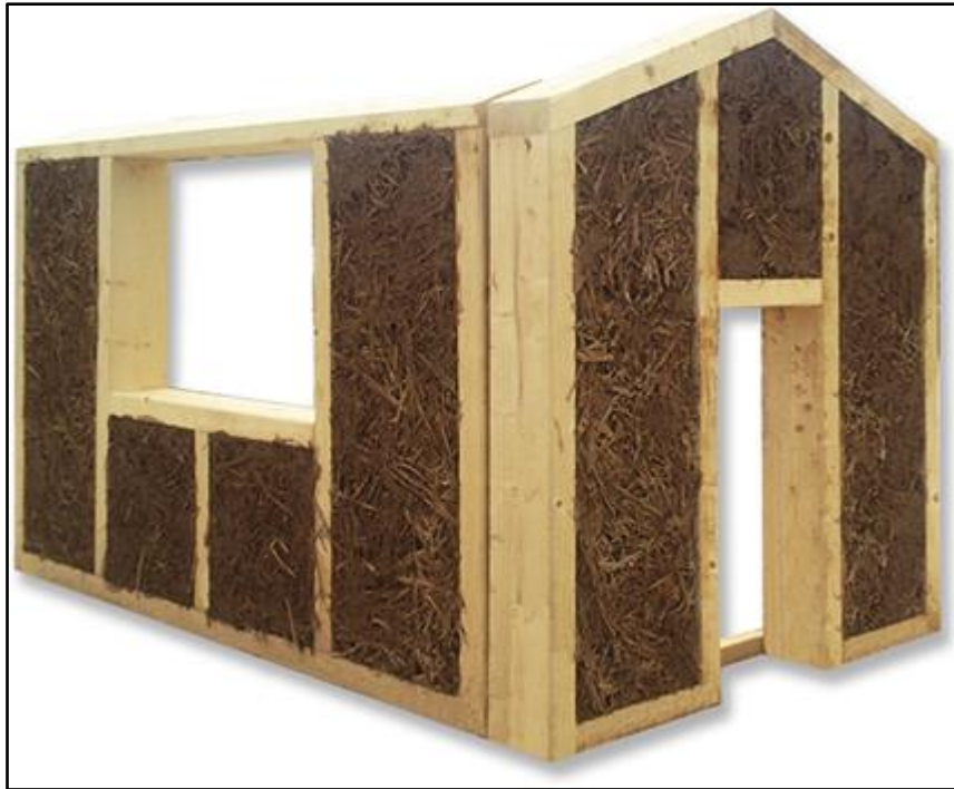
Figura 4.16. Panel modular aligerado de tierra y paja Swallow Brick. 90
