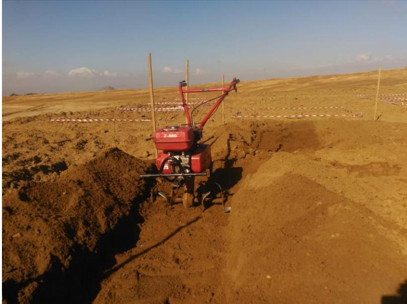
*Ilustración 2. Proceso de homogenización del suelo utilizando un motocultor.*
