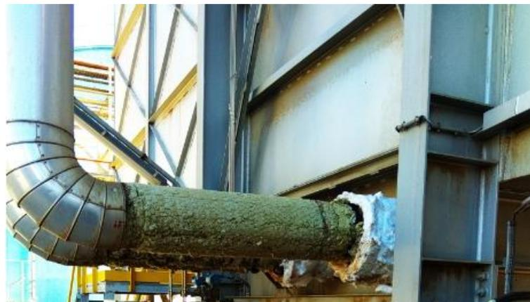
**Imagen 3. Instalación aislamiento en tuberías**
