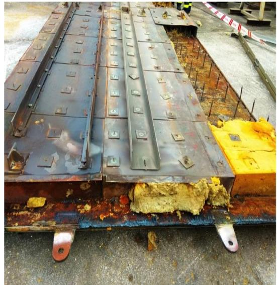
**Imagen 1-2. Instalación aislamiento interior caldera**
