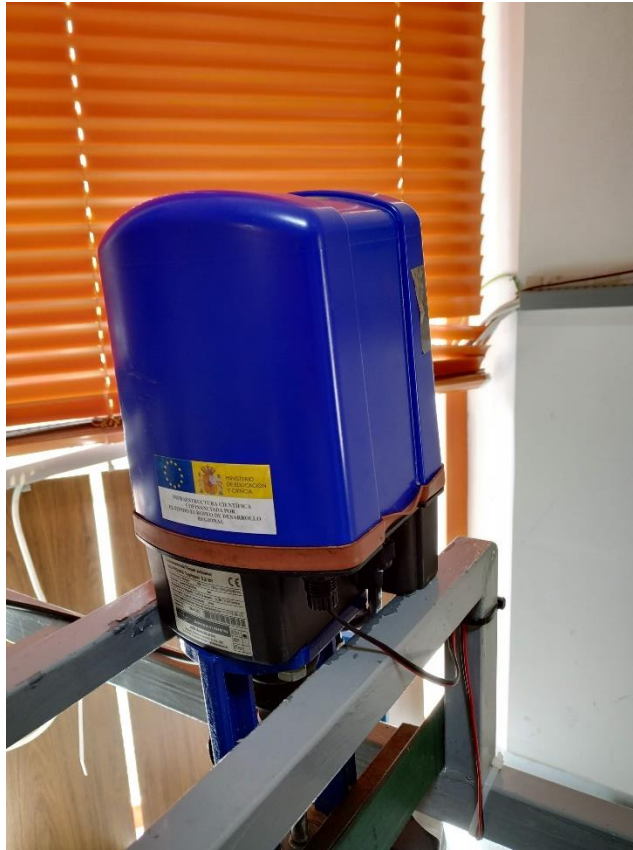
Figura 2. 6. Electroválvula de tres vías
