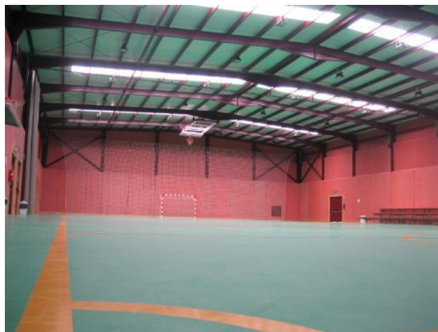
Figura 79. Pista deportiva con puerta de emergencia y rejilla de ventilación (fondo)
