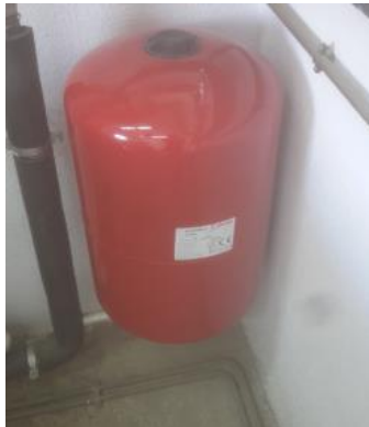
Figura 76. Vaso de expansión
