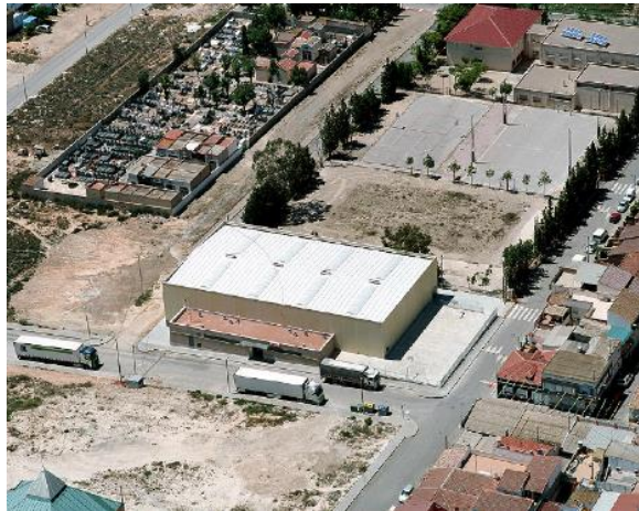
Figura 100. Pabellón Sangonera la Seca visto desde el aire
