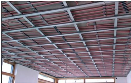
Figura 16. Techo radiante
