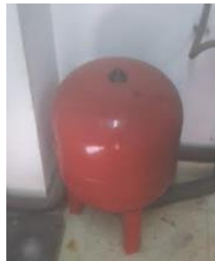
Figura 41. Vaso de expansión
