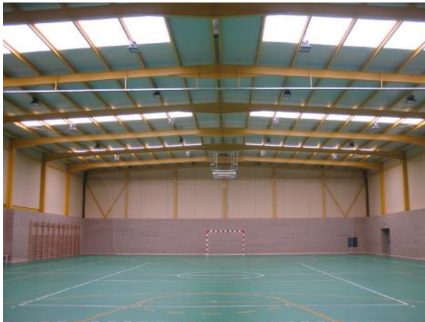
Figura 111. Pista deportiva con puerta de emergencia y rejilla de ventilación (fondo)
