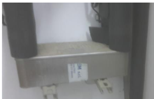
Figura 86. Intercambiador de placas
