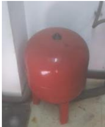
Figura 73. Vaso de expansión
