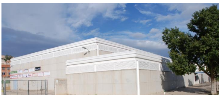
Figura 33. Exterior del Pabellón Cabezo de Torres
