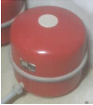
Figura 106. Vaso de expansión
