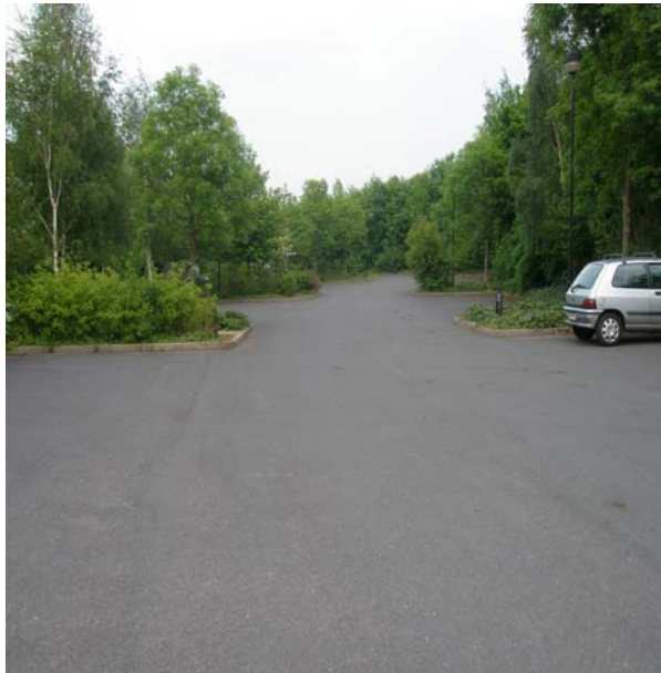
Figura 2.3 Parking de asfalto donde se han ejecutado los experimentos
