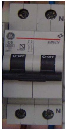
Figura 2.47- Magnetotérmico
