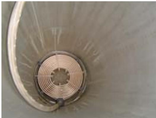
Figura 2. 32- Resistencia de inmersión del depósito D-01
