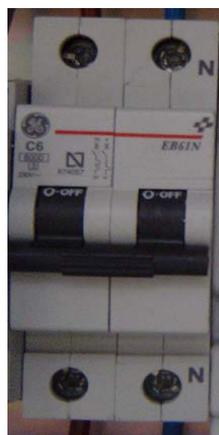
Figura 2.23. Magnetotérmico
