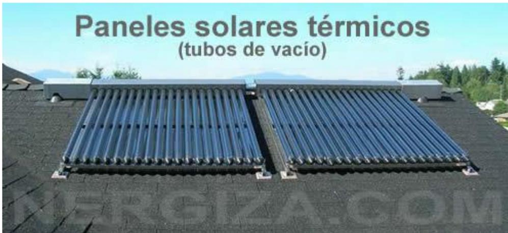
*Figura 3: colectores de tubos de vacío.*
