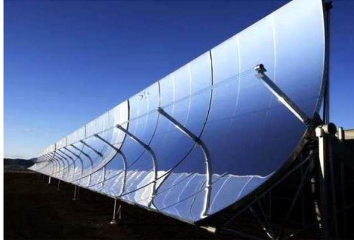
*Figura 2: colectores de concentración.*
