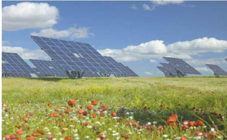
*Figura 40: Instalación sobre suelo con sistemas de seguimiento.*
