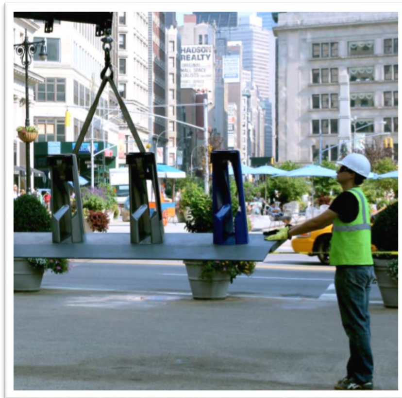
Figura 2: Colocación de un sistema modular, móvil y de celdas solares. (Tercera generación). Fuente: Guía de planeación del sistema de bicicleta pública.
