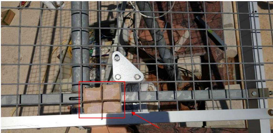
**Figura 17.** Herramienta utilizada para verificar el correcto alineamiento del seguidor respecto al sol, en ella se verifica que no existe sombra alguna indicando así que el seguidor se encuentra alineado correctamente.
