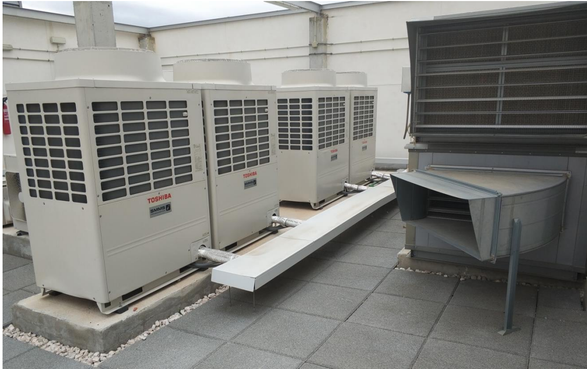
Figura 4.13 Unidades MMY-MAP1404HT8 y MMY-MAP1604HT8 en la instalación junto a la UTA.
