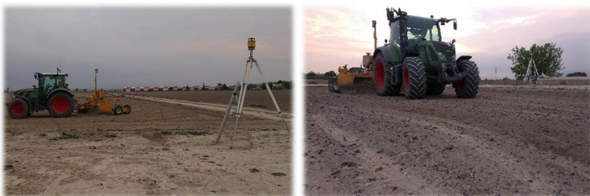
Figura 35. Nivelación láser del terreno.
