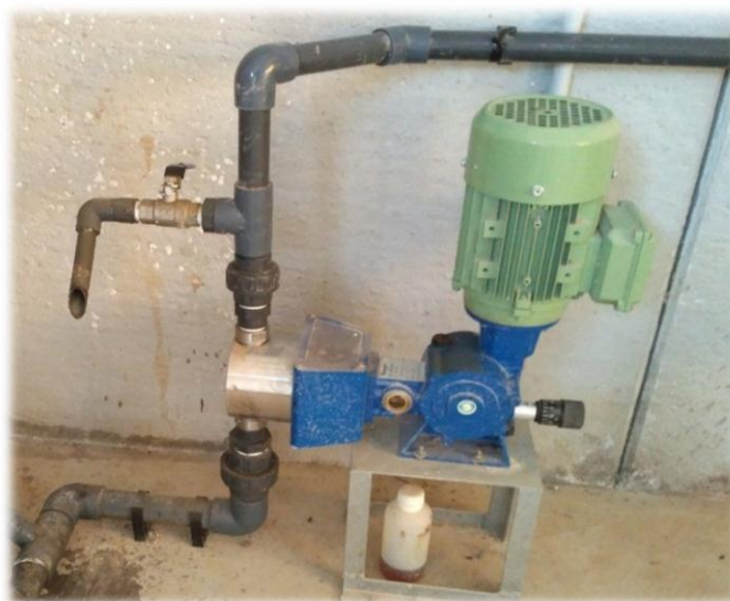
Figura 48. Sistema de inyección con bomba inyectora regulable para riego por goteo.
