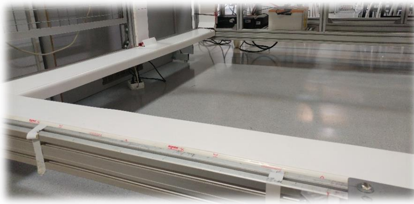
Ilustración 54. Canaletas conductoras de reciente instalación
