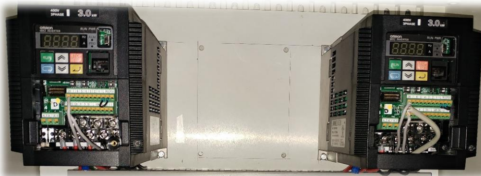
Ilustración 71. Conexión en paralelo de variadores de frecuencia
