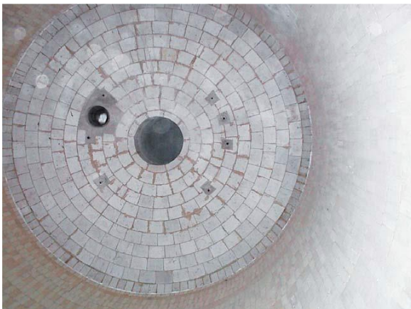
Figura 4 22 cúpula refractaria Fuente www.degremont.com/
