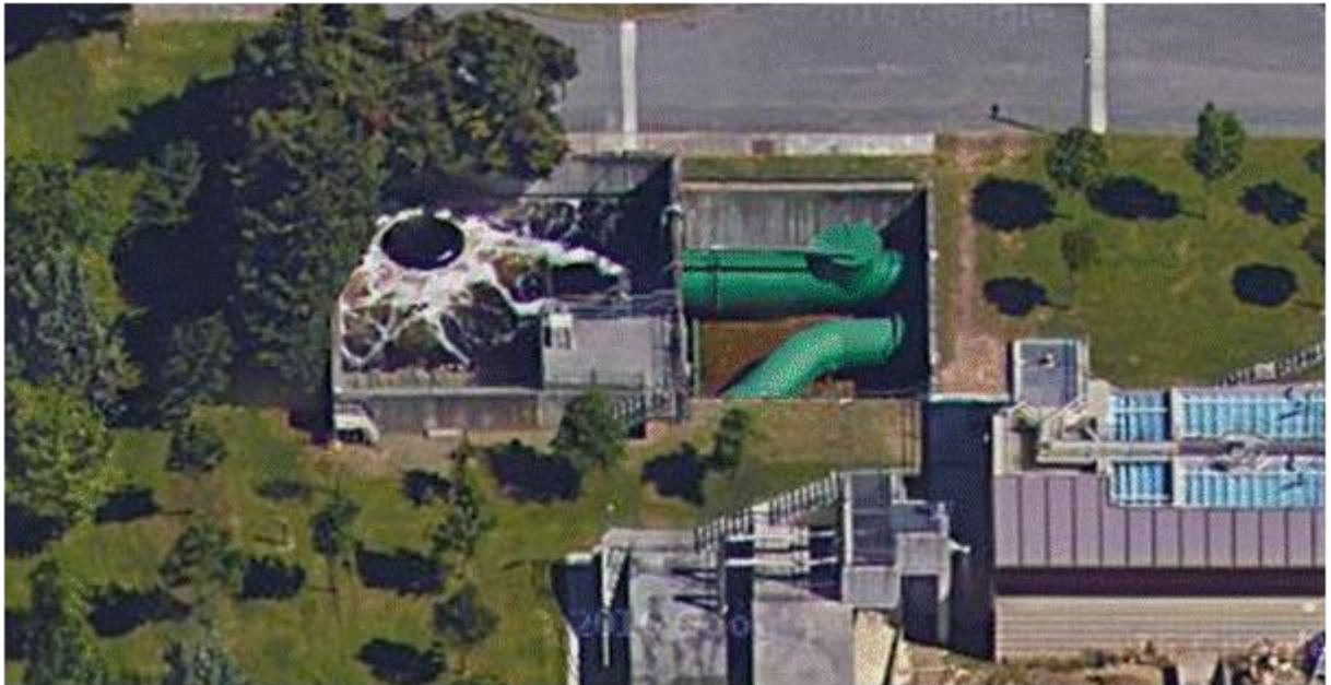
Figura 4 6...tratamiento terciario y salida del efluente...
