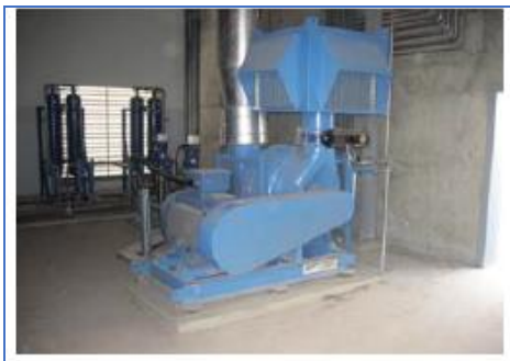
Figura 4 21 ventilador de alta presión Fuente: www.degremont.com/
