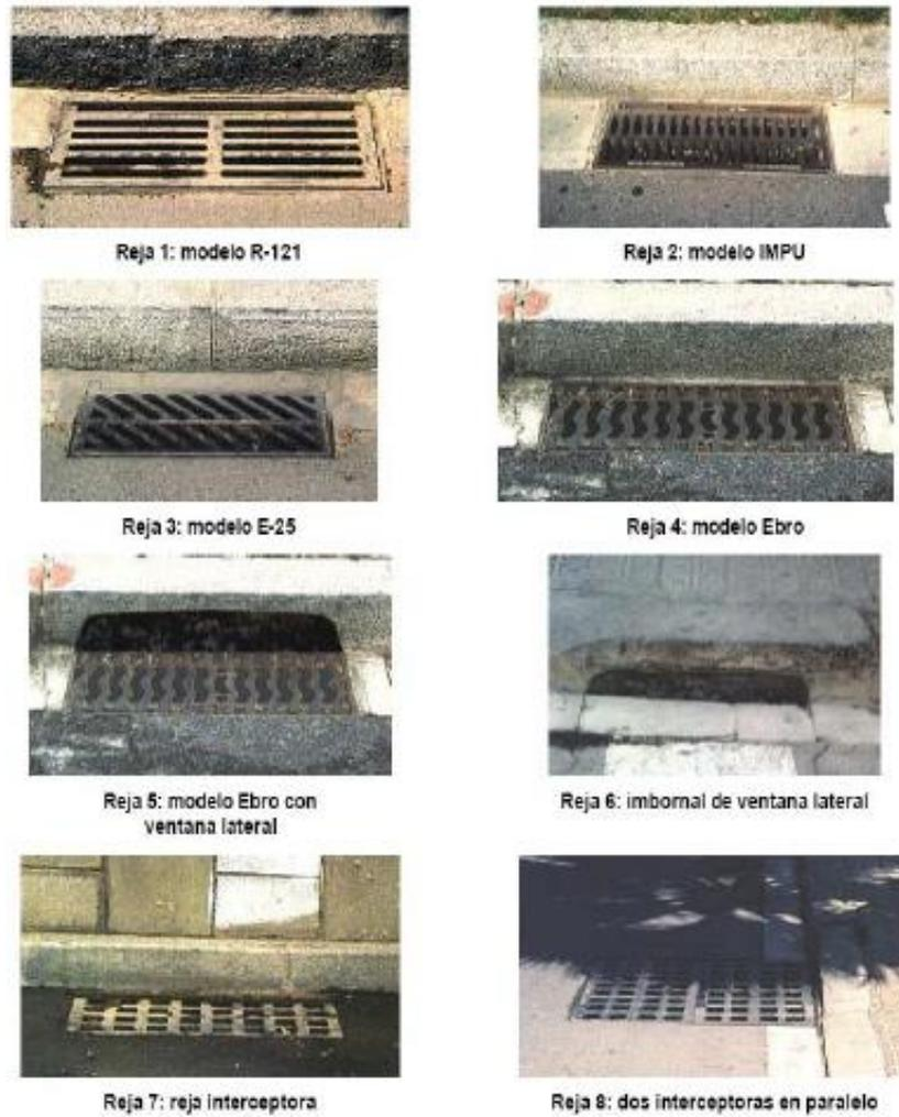
Figura 4.10: Tipos de rejillas ensayadas
