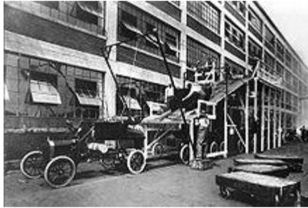
1913 experimentando con un cuerpo montado del chasis del Modelo T. Ford probó varios métodos de ensamble para optimizar los procedimientos antes de instalar de manera permanente todo el equipo. La línea de ensamble actual utiliza una grúa elevada para montar el cuerpo.
