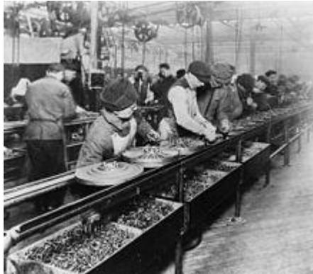
Línea de ensamble Ford, 1913. El magneto de la línea de ensamble fue el primero.
