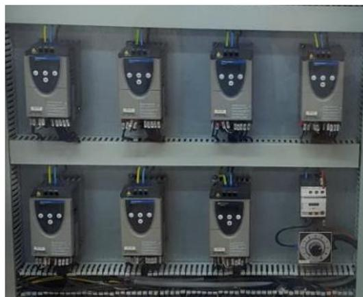
Figura 2.9: Armario contenedor de los variadores de frecuencia
