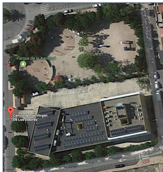
Figura 9. Vista superior del edificio
