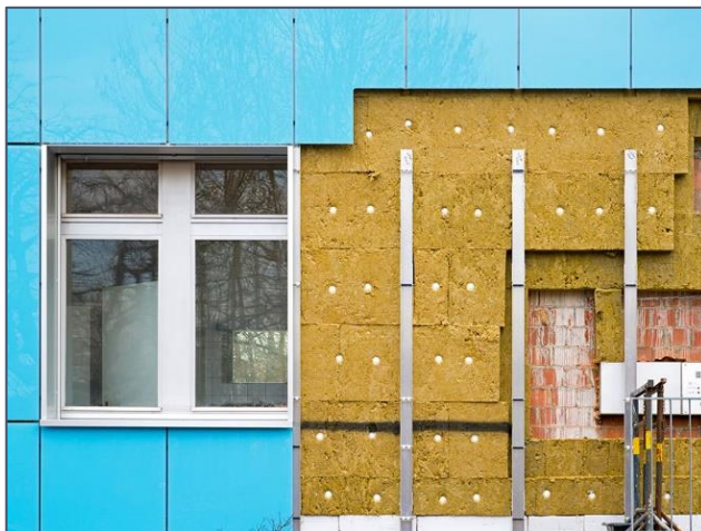
Figura 36. Instalación aislamiento en fachada por el exterior
