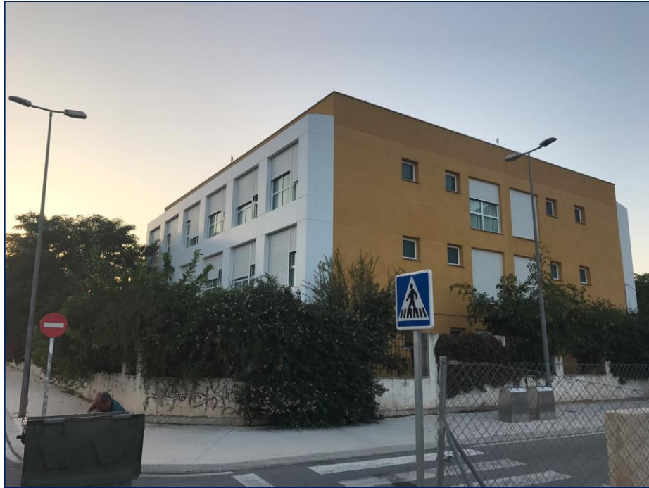
Figura 4. Fachadas sur y este del edificio
