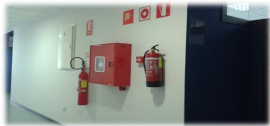
Figura 11; Extintores, mangueras.
