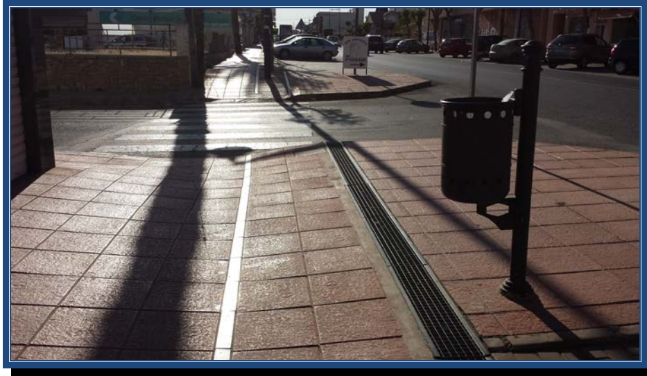
Foto N°7:Rejillas en Avda. de Balsicas, fachada Farmacia
