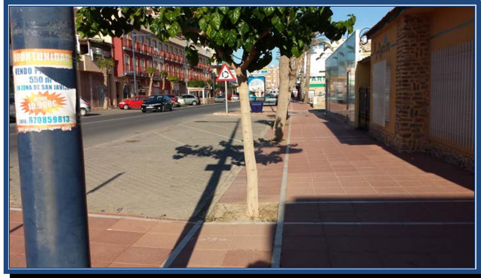
Foto N°5: Unisión de aparcamientos y aceras en Avda. de Balsicas
