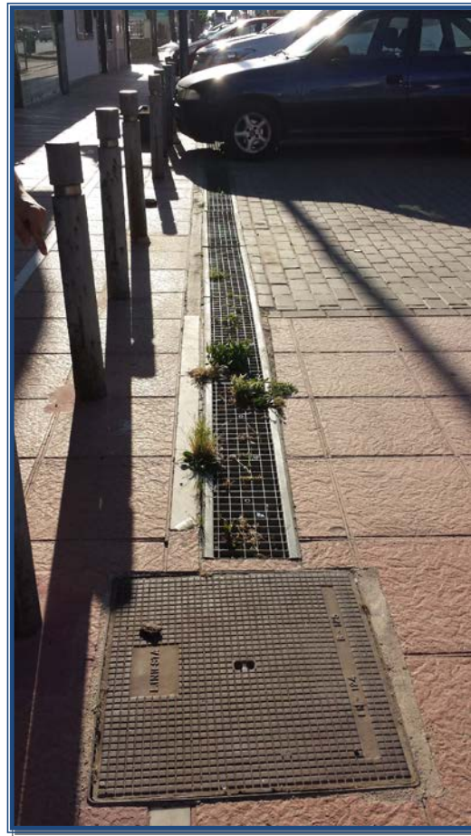
Foto N°9: Rejillas en Avda. de Balsicas, fachada Farmacia
