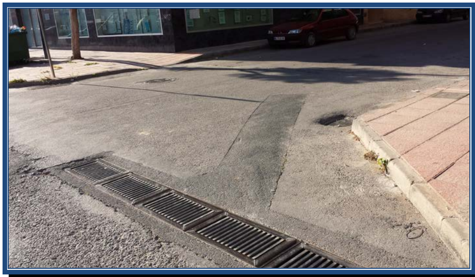
Foto N°10: Rejillas en Avda. de Balsicas con C/ Góngora
