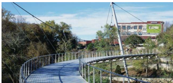
Fig. 1. Pasarela de Liberty Bridge, Greenville.
