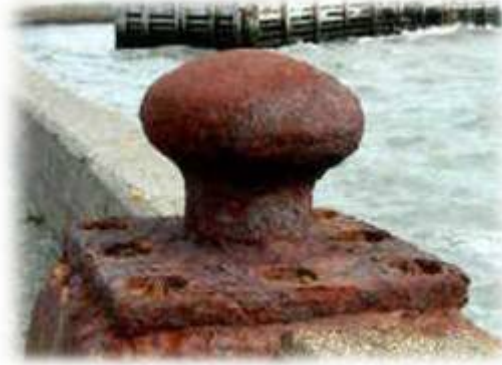
Figura 1. Ejemplo corrosión uniforme, Mantenimiento Industrial [2015]
