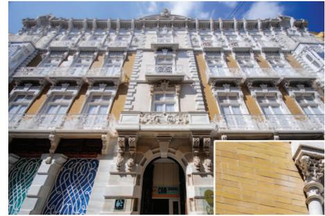
[FIG. 11] VISTA DE LA 'CASA CERVANTES' (1897-1900) DEL ARQUITECTO VÍCTOR BELTRÍ. EN LA ESQUINA INFERIOR DERECHA, DETALLE DEL LADRILLO EMPLEADO, PENSADO DE BORDE RECTO Y ACABADO ESMALTADO. LA FÁBRICA ESTÁ COMPUESTA CON APAREJO A 'SOGA'. [FOTOGRAFÍA DEL AUTOR]
