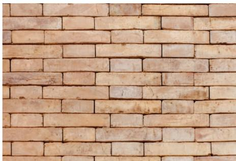
[FIG. 10] APAREJO BELGA O FLAMENCO UTILIZADO EN UN EDIFICIO DE LA CALLE MORERÍA BAJA. EL LADRILLO UTILIZADO ES PRENSADO DE BORDE RECTO. [FOTOGRAFÍA DEL AUTOR]
