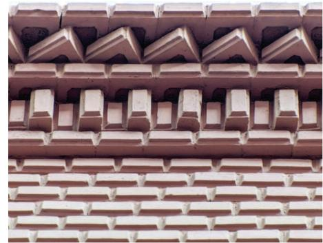
[FIG. 7] LADRILLO PRENSADO DE BORDE MOLDURADO EN FACHADA Y CORNISA DE EDIFICIO SITUADO EN CALLE SAURA. SE APRECIA QUE EL MOLDURADO SÓLO SE EJECUTA EN UNA DE LAS CARAS. TAMBIÉN SE VE EL REHUNDIDO EN LA TABLA PRODUCIDO POR EL MOLDE DE LA PRENSA, CON EL SELLO DE LA FÁBRICA. [FOTOGRAFÍA DEL AUTOR].
