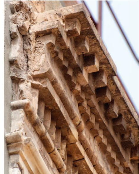
[FIG. 5] DETALLE DE CORNISA DE EDIFICIO EN CALLE MORERÍA BAJA, TRASERA DEL PASAJE CONESA. SE APRECIA EL USO DE LADRILLOS CON FORMAS ESPECIALES, FABRICADOS CON MOLDES ESPECÍFICOS Y APLANTILLADOS. [FOTOGRAFÍA DEL AUTOR].
