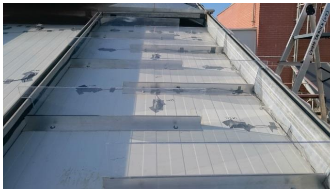
Figura 4.9. Instalación de sondas de temperatura en el panel aislante de la configuración B.
