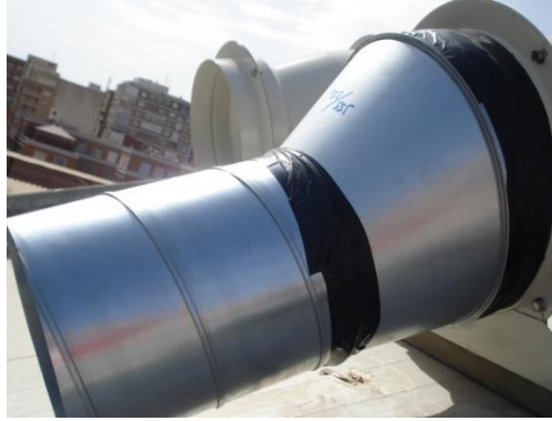
Figura 4.6. Acoplamiento de la reducción excéntrica al ventilador.
