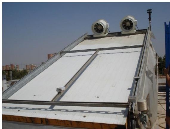
Figura 4.3. Disposición de los perfiles del marco de sujeción de los paneles fotovoltaicos.
