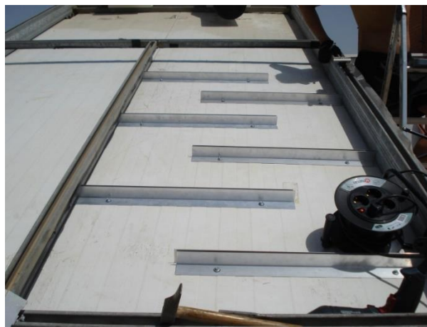
Figura 4.5. Disposición de las guías de aluminio para la sujeción de las placas intercaladas.
