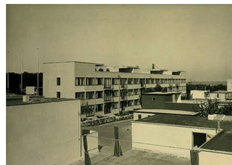
FIG. [16.1] VISTA DE LA CUBIERTA DE LA VIVIENDA 16 DE GROPIUS, FOTOGRAFÍA DE MIES VAN DER ROHE PUBLICADA EN EL CATÁLOGO DIGITAL DE LA CASA DE SUBASTAS JESCHKE, HAUFF & AUVERMANN.
