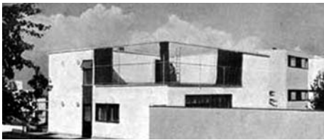
FIGS. [8] VISTAS DE LA VIVIENDA 16 DESDE LA CALLE BRUCKMAN- NWEIG. ARCHIVO DE LA BAUHAUS (BHA) EN BERLÍN, 1927.
