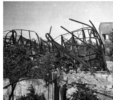
FIG. [20] VISTA DE LA VIVIENDA 17 DESTRUIDA DURANTE LA SEGUNDA GUERRA MUNDIAL. FOTOGRAFÍA EXPUESTA EN EL WEIßENHOFMUSEUM DE STUTTGART, 1947.
