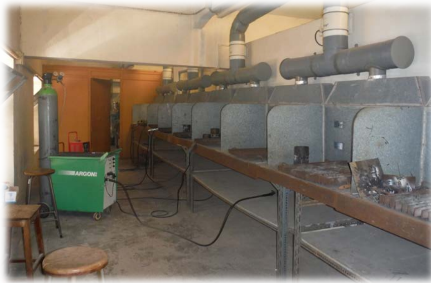
Figura 4. Sala de soldadura eléctrica del Taller de Fabricación Mecánica antes de su traslado al edificio ELDI. Fuente: Elaboración propia.
