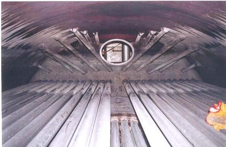
Foto Arrastre de condensado por excesiva concentración de sólidos.
