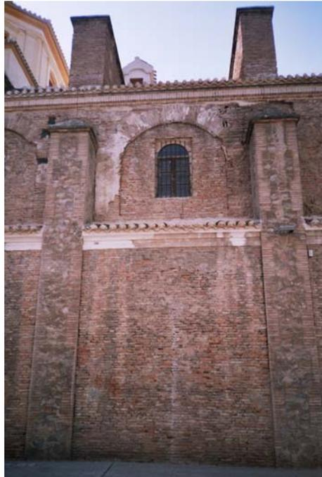
Fig. 8. Estado actual en el que se conservan los contrafuertes, muros de capillas laterales, restos del mortero de cal y yeso pertenecientes a la fase Ib.
