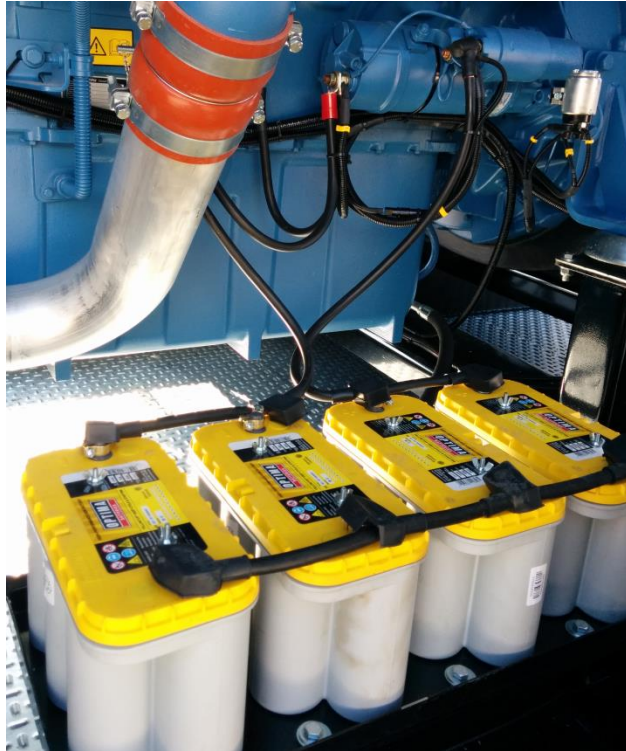
Figura 3.1. Sistema de arranque grupo electrógeno gama pesada
