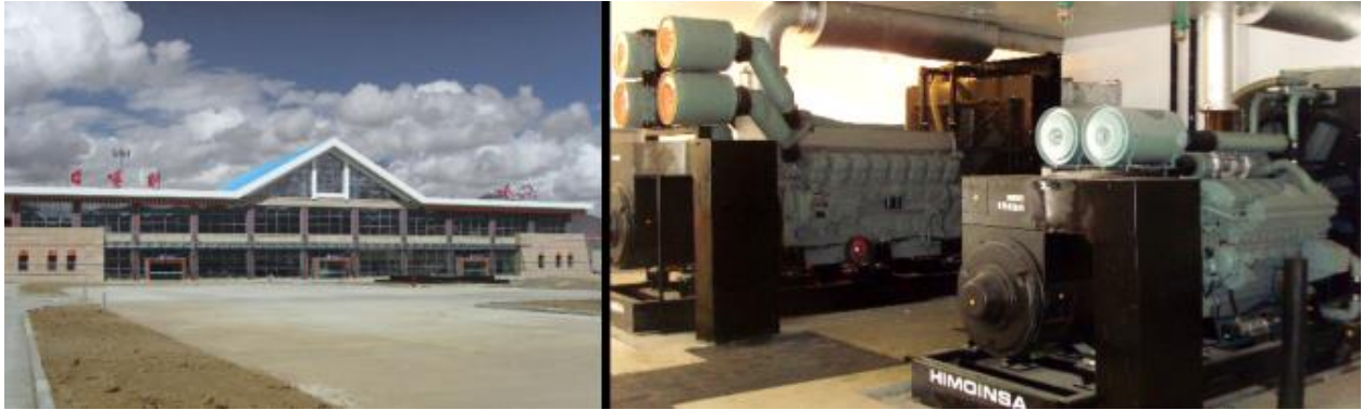
Figura 2.25. Grupos electrógenos de emergencia en el Aeropuerto del Tíbet
