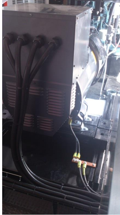
Figura 3.18. Sistemas de transmisión de potencia alternador-cuadro
