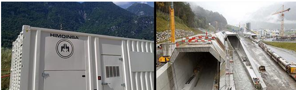
Figura 2.24. Grupos electrógenos para suministro de energía del túnel ferroviario del Gotardo
