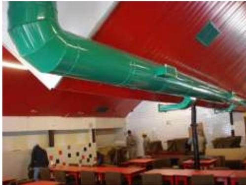
Ilustración 44: Tuberías de ventilación.
