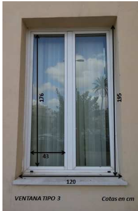
Figura 11. Detalle y cotas de ventana tipo 3.
