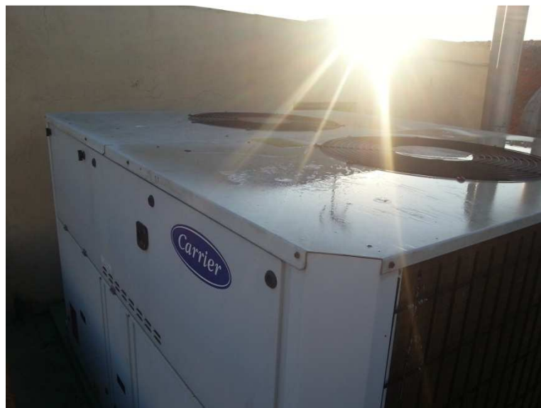
Figura 27. Enfriadoras CARRIER 30RH160. Imagen 2.
