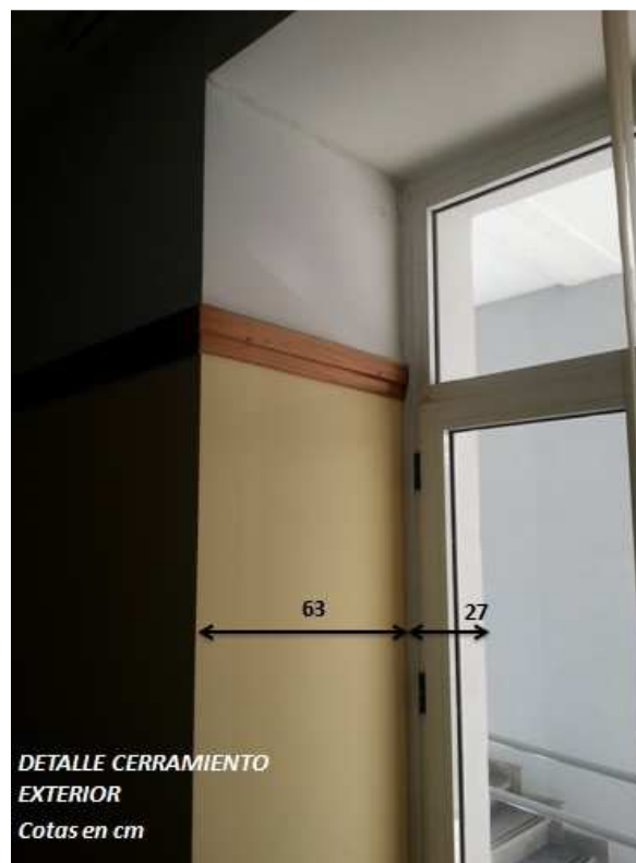
Figura 3. Espesor del cerramiento exterior.
