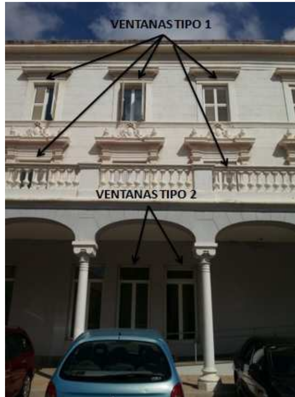
Figura 8. Ventanas tipo en fachada principal (sur).
