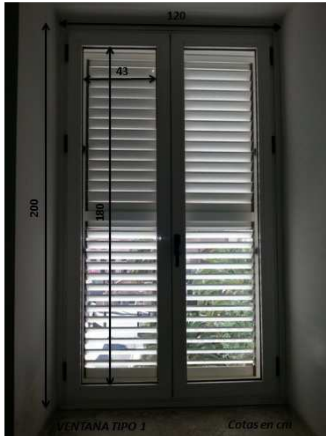
Figura 10. Detalle y cotas de ventana tipo 1.
