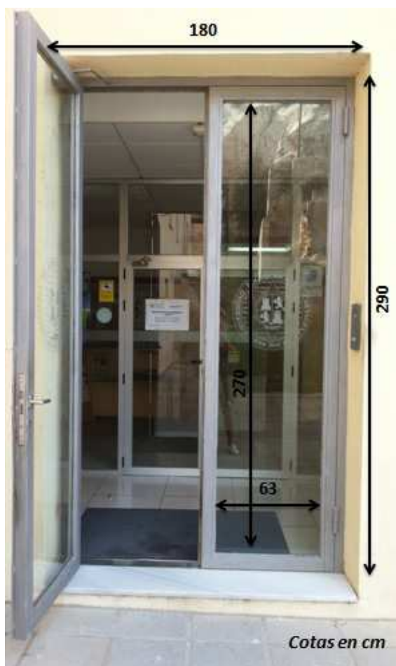
Figura 12. Detalle y cotas de puerta trasera.
