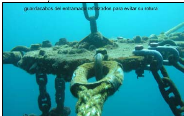
Foto 9 Plato con entramado de cabo y guardacabo. conexiones y grilletes de 17 Tn
