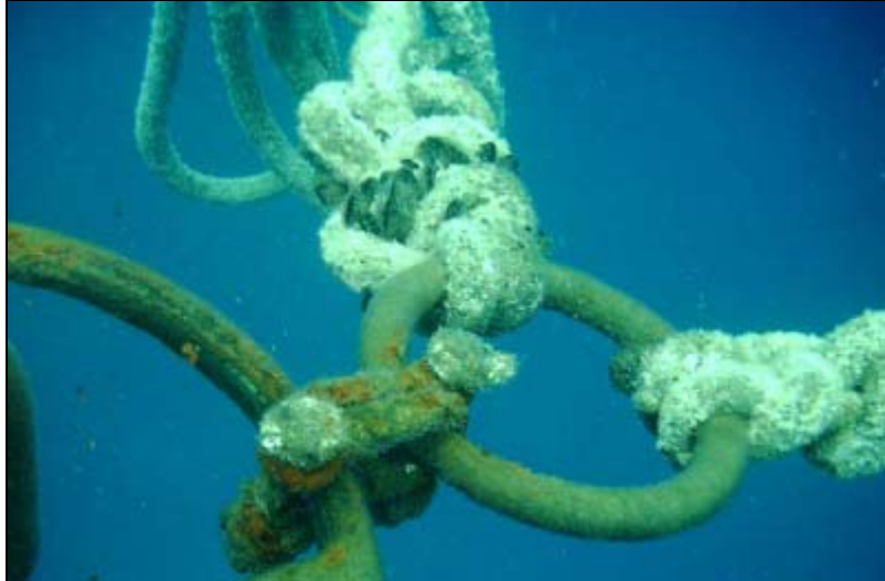
Foto 7 Fallo bastante común, dos cabos a un solo anillo.
