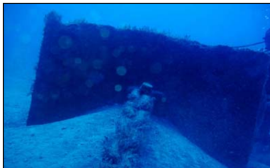
Foto2 Unión de la cadena de fondo con el último bloque.
