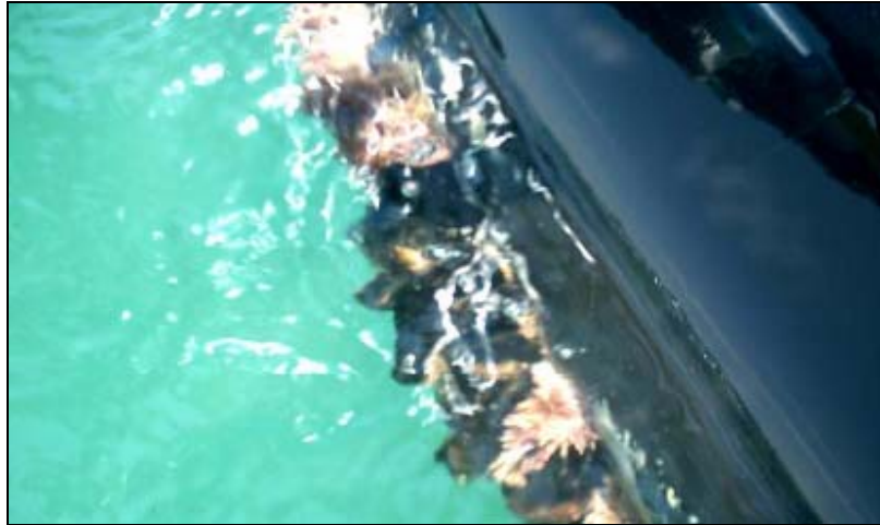
Foto 26 Mejillones en los tubos.
