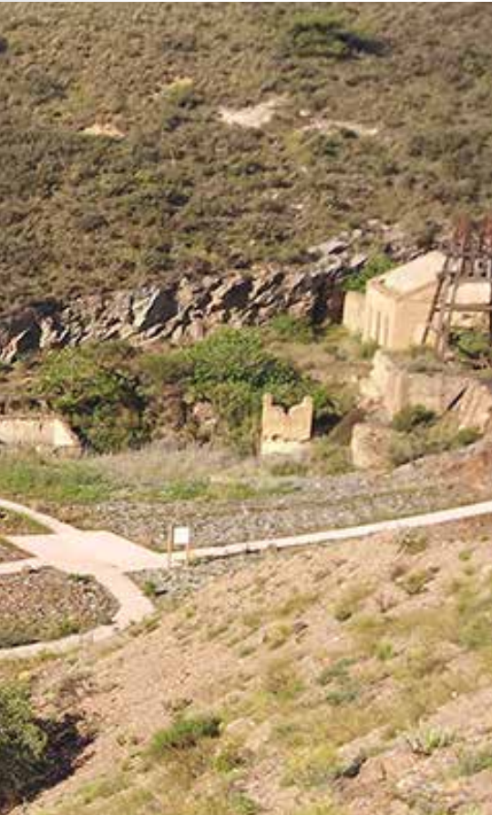
Panorámica del paisaje descontaminado de la antigua mina Santa Antonieta, cuyas instalaciones se ven a la derecha de la imagen.
