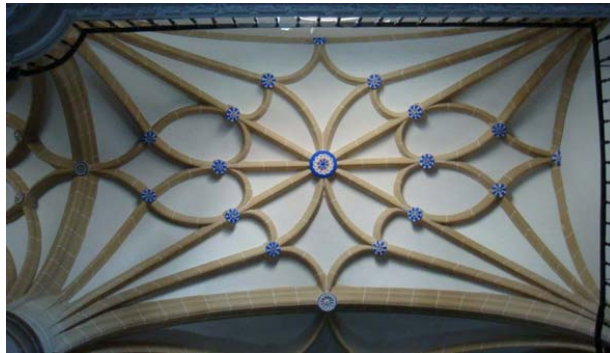
Fig 3. Bóveda de crucería perlongada. Garcinarro.
