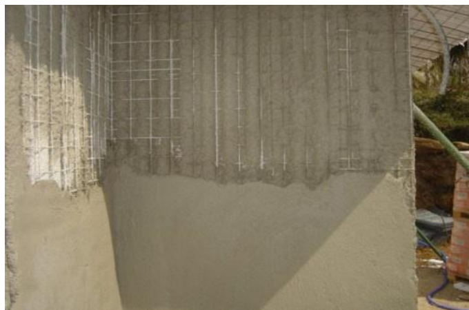
Fotografía 11. Microhormigón proyectado
