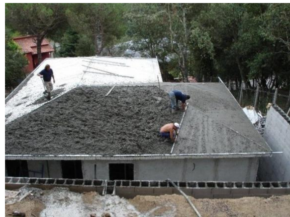
Fotografía 38. Hormigonado de capa de compresión
