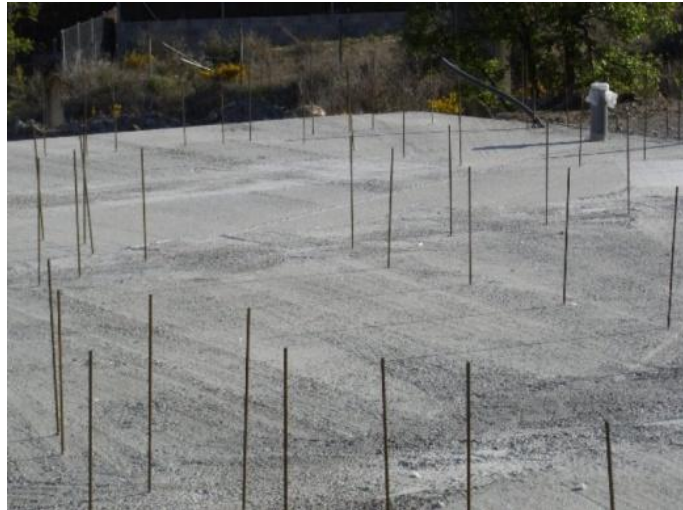
Fotografía 13. Colocación de las esperas en el hormigón
