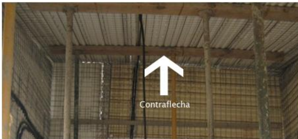
Fotografía 22. Aplicación contraflecha en el centro del forjado
