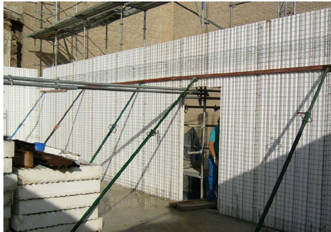
Fotografía 17. Detalle aplomado mediante puntales metálicos
