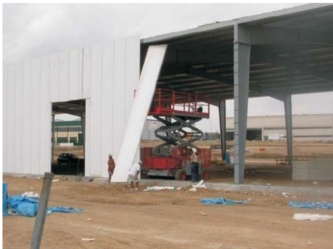
Fotografía 30. Paneles EPS portantes en nave industrial
