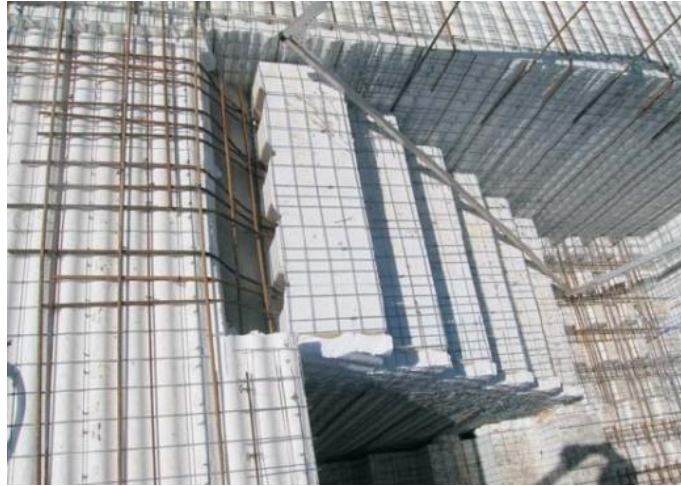
Fotografía 28. Detalle del armado del anclado en forjado
