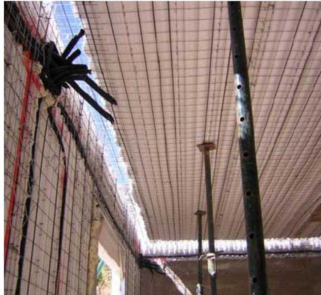
Fotografía 18. Detalle entre muro y forjado
