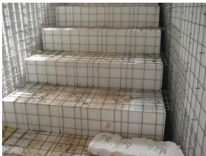
Fotografía 23. Paneles EPS formación zanjas escalones de la escalera
