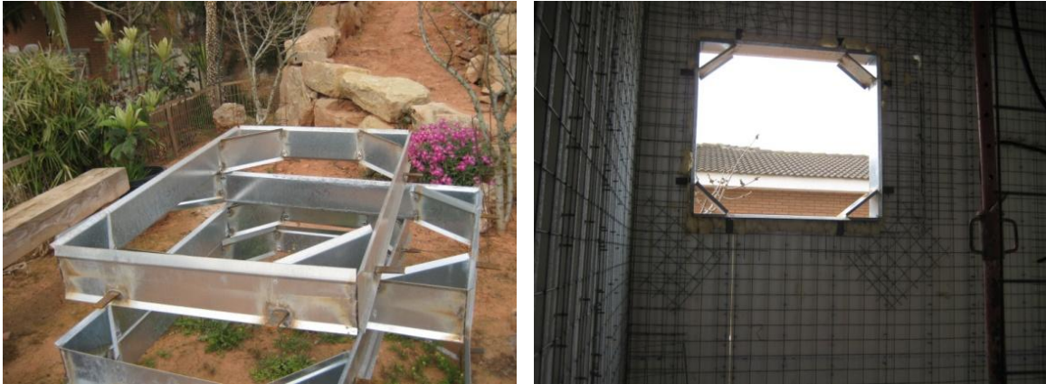
Fotografía 15. Detalle premarcos carpintería de aluminio
