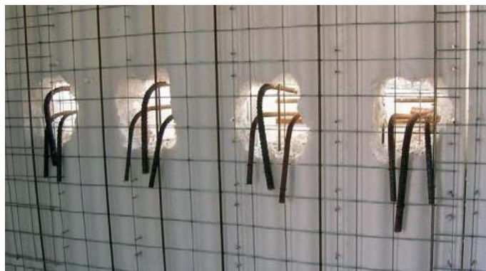
Fotografía 26. Conexión armadura escalones con muro
