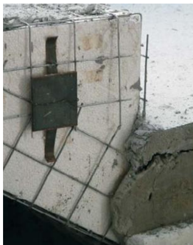
Fotografía 27. Detalle del anclaje
