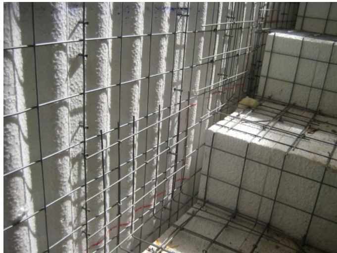
Fotografía 25. Detalle MA escalera
