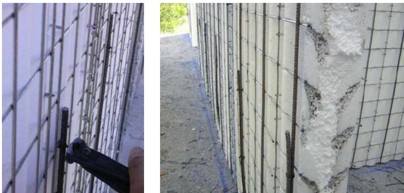
Fotografía 16. Atado de paneles
