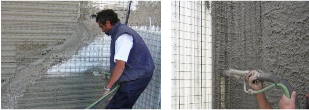
Fotografía 36. Aplicación microhormigón en paredes verticales
