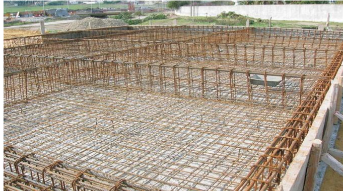
Fotografía 12. Proceso de cimentación
