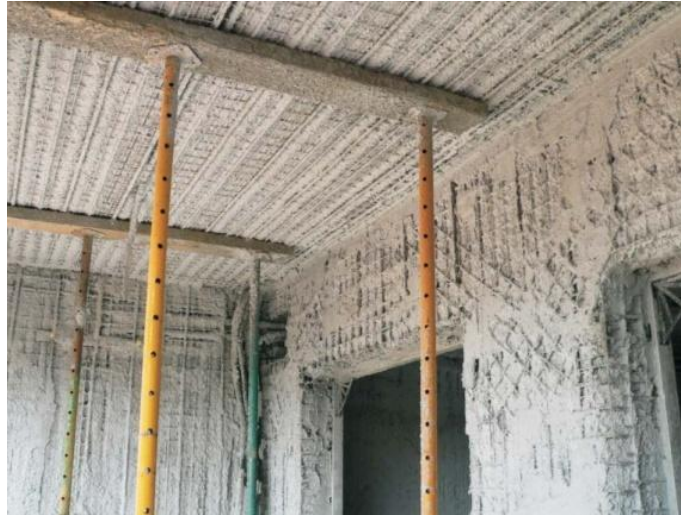
Fotografía 37. Hormigonado de forjados
