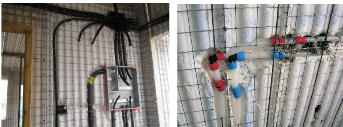
Fotografía 34. Paso de instalaciones
