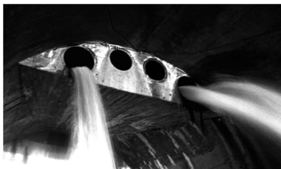
Fig. 2. Salida de las tomas del embalse
